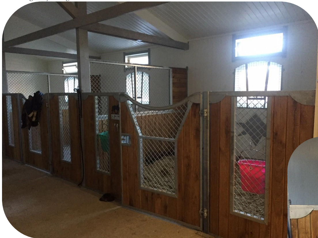
Ruter Ess med ljusinsläpp enligt figur 2 ovan i ett stall från Bruksbalken.
